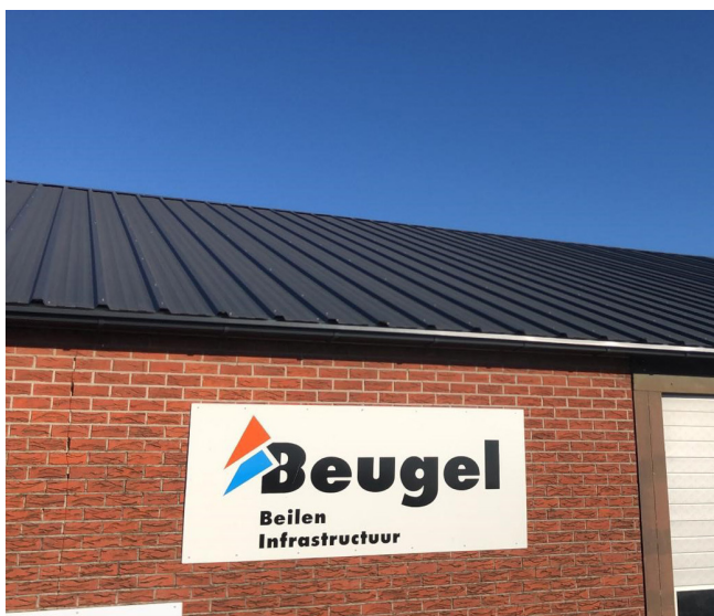
Het nieuwe dak op de loods van Beugel
