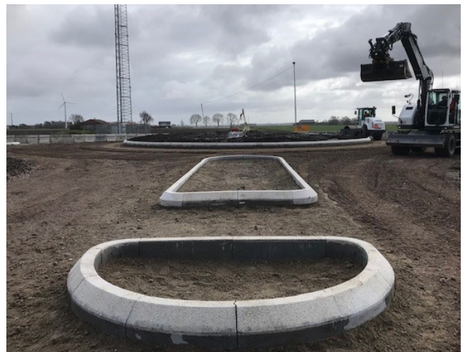
De geleiders van de rotonde worden gevuld met grind
